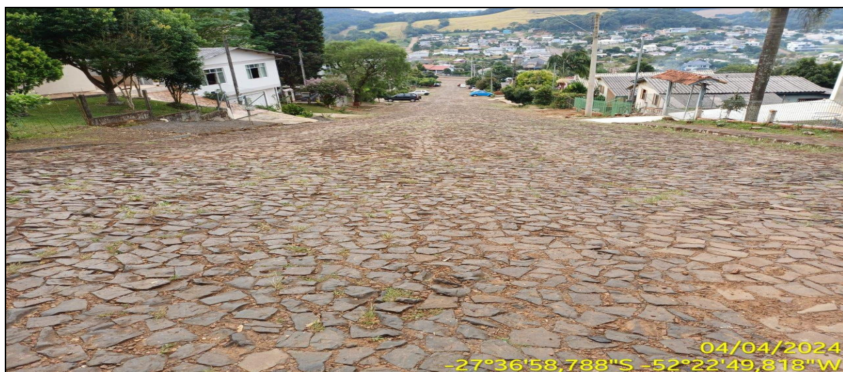
3.2 - Rua Bela Vista entroncamento com a Rua Esperança - sentido Leste
