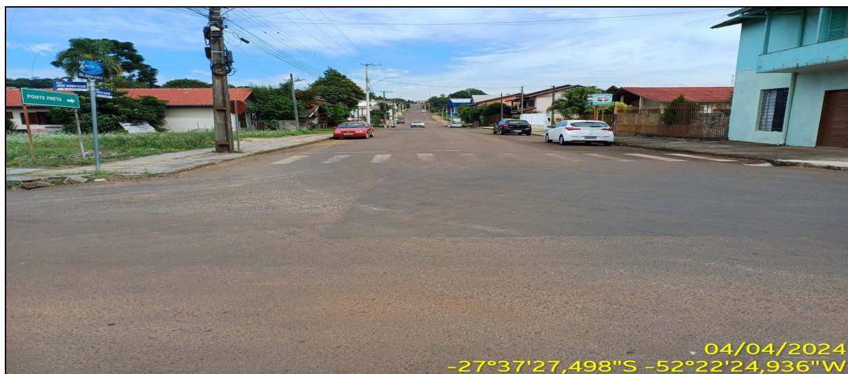
1.6 - Rua Porto Alegre entroncamento com Rua José Bonifácio - Sentido Oeste
