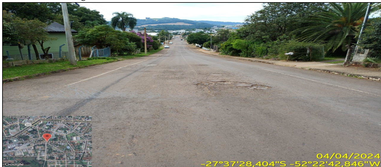
1.1 - Rua Porto Alegre entroncamento com a Avenida 21 de Abril - sentido Leste.
