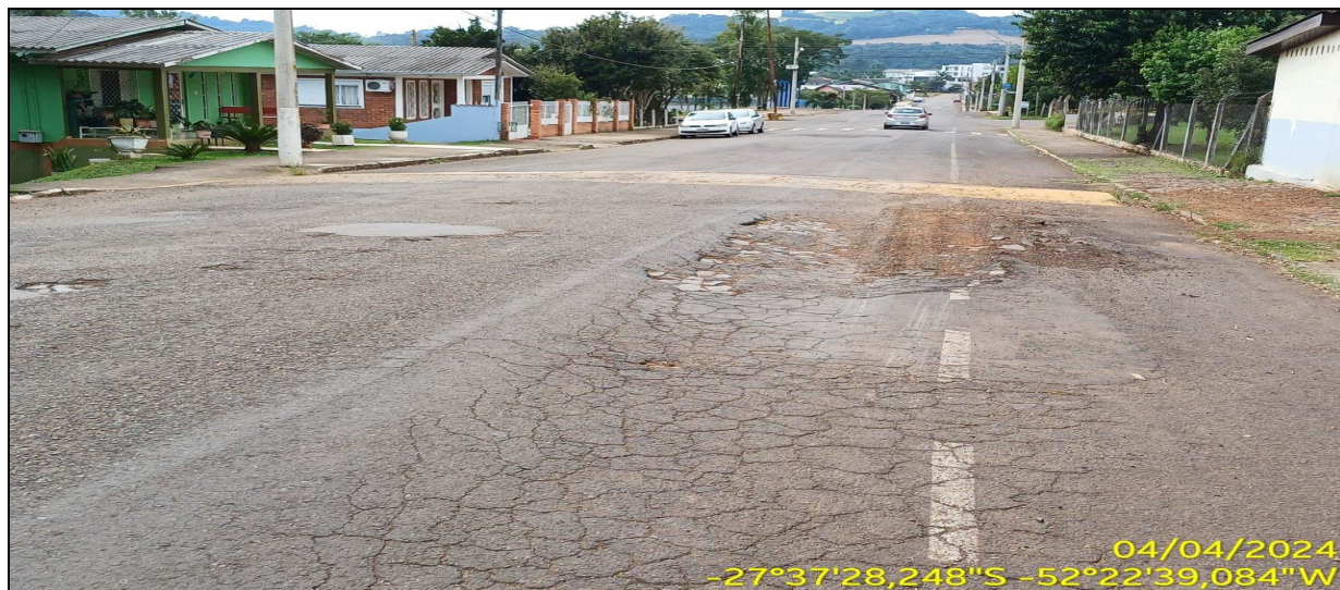
1.2 - Rua Porto Alegre - área de reparo - proximidades CRAS
