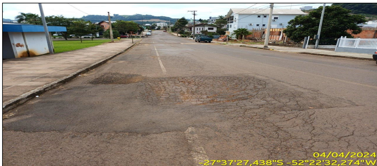
1.5 - Rua Porto Alegre área de reparo - proximidades do Ginásio de Esportes
